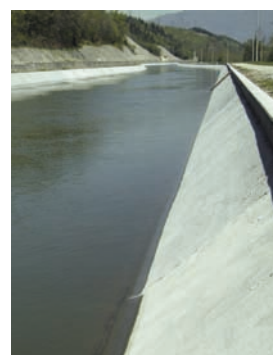
Canale Enel - Lazise
