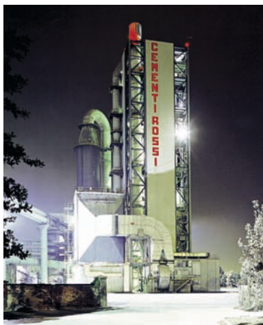
Stabilimento Cementirossi di Piacenza
